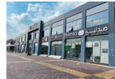
EIZO Middle East Ltd.が入居するビル外観
