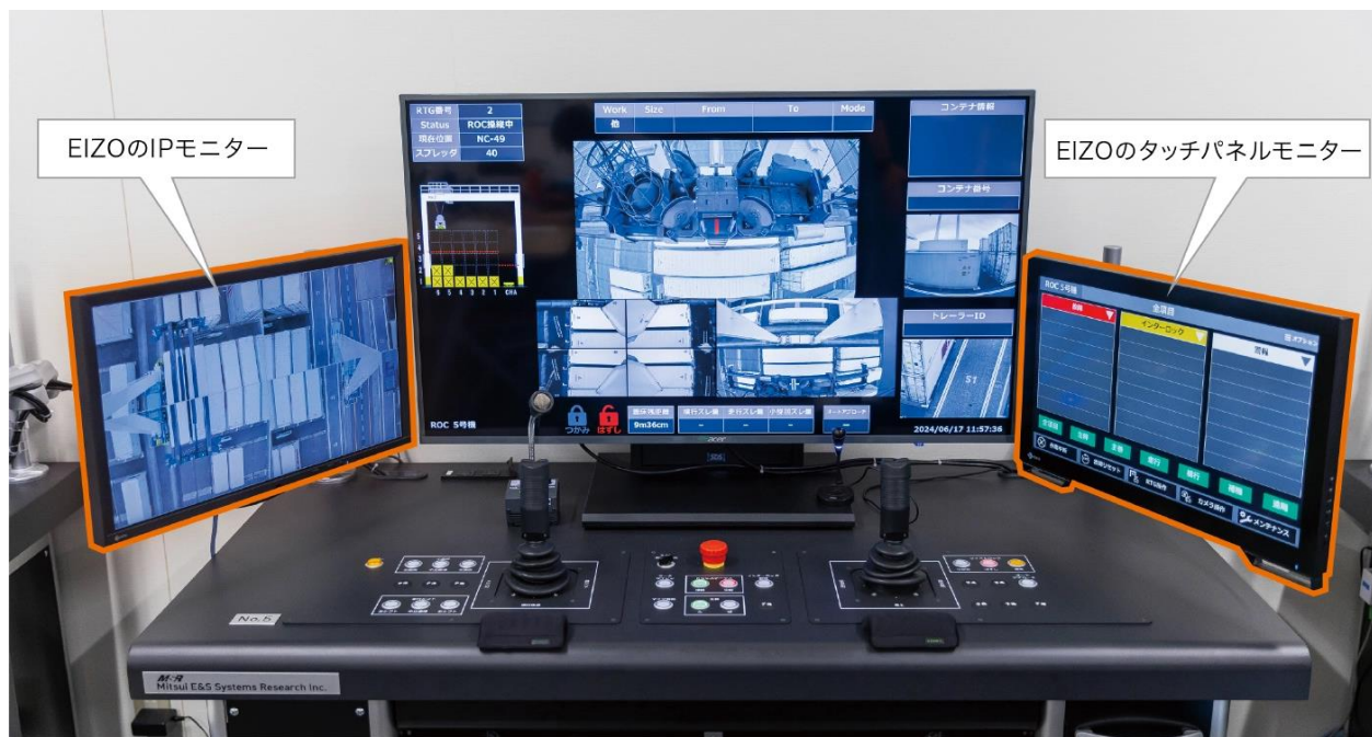
管理棟にある遠隔操作卓
