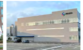
EIZOエムエス株式会社 新工場棟を竣工(2020.10)
