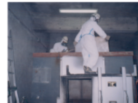
●焼却炉の解体
